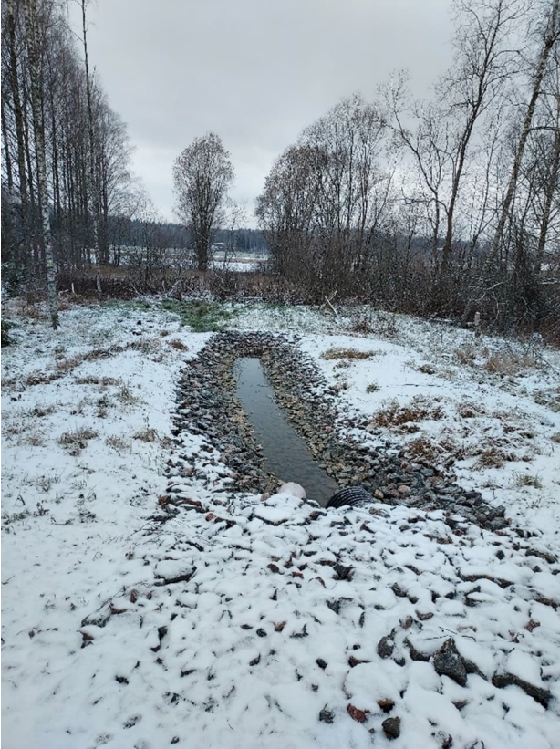
Ns. ala-allas (22.11.2023), josta vesi laskee osittain maaperän läpi suotautuen "alempaan pisto-ojaan" ja edelleen Kirjokallionoja 3-haaraan.
